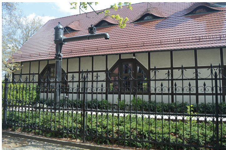
Dworzec Wrocław Wąskotorowy po renowacji. Fot. P. Sendeki
