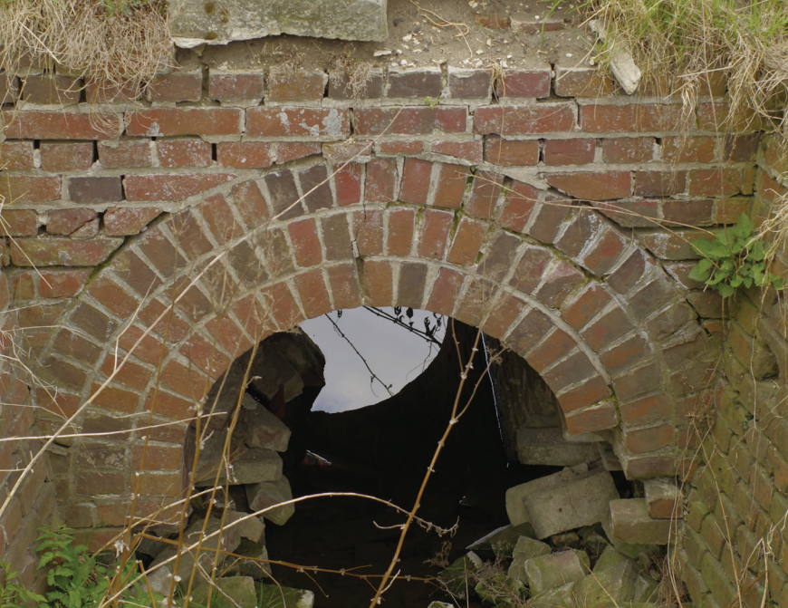
Sklepiony przepust na trasie kolejki - okolice Wziąchowa Wielkiego. Fot. C. Tajer
